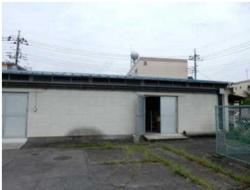
水防倉庫 (渋川土木)
